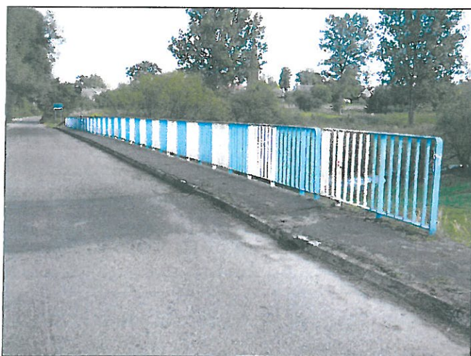
fot. 11. Chodnik od g. wody. Normatywne „światło” dla pieszych – 123cm.
