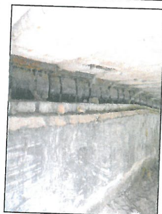
fol. 3. Dobry stan techniczny przyczółków i filarów. Brak zabezpieczenia antykorozyjnego powierzchni betonowych filarów. Oznaki wstępne korozji łożysk wałkowych. Do odtworzenia skarpy brzegowe.
